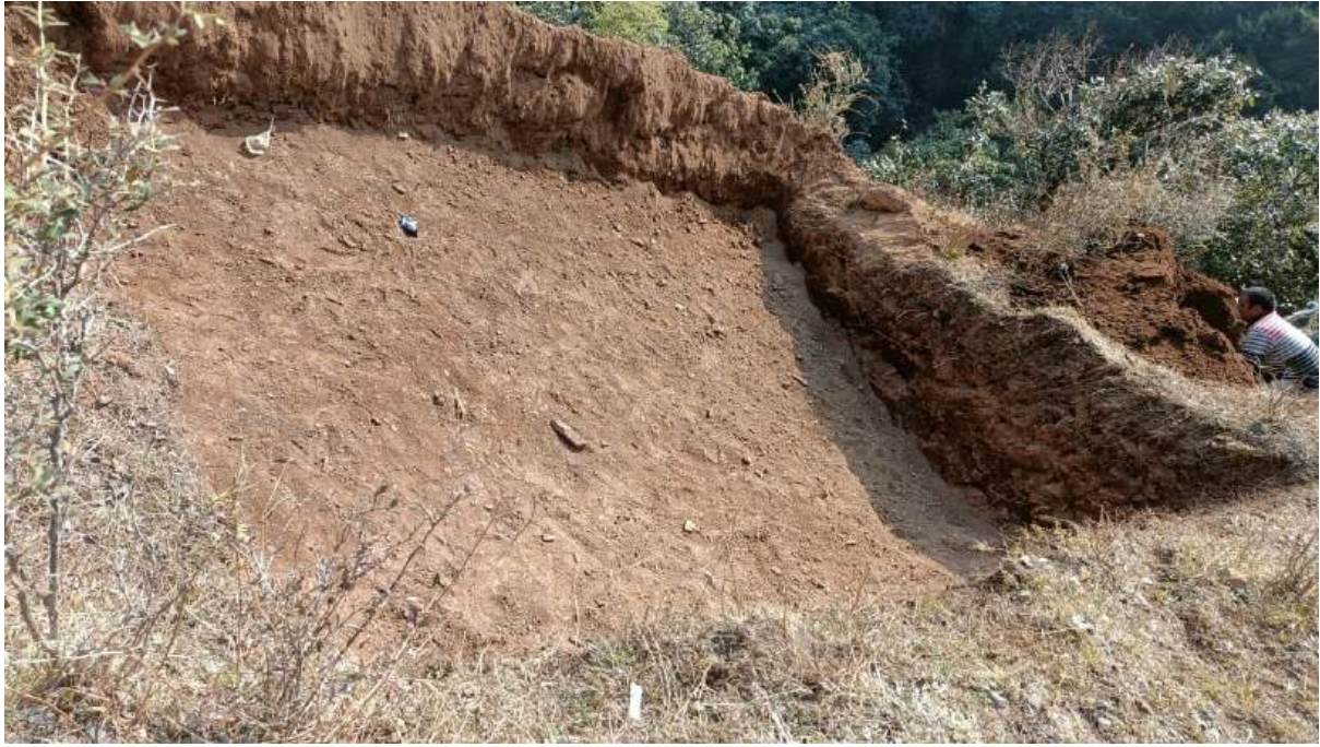
रतनालीगाड जल स्रोत में कन्टूर ट्रेंच निर्माण कार्य
