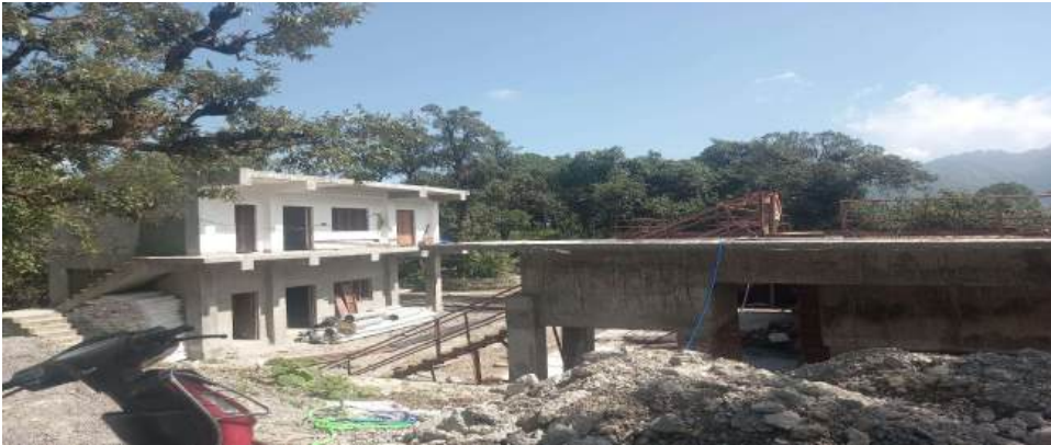
Bhiladu STP 1.10 MLD
